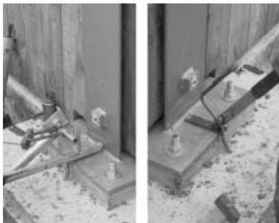
Fig. 12 Mit eigens konstruierten Abbiegewerkzeugen konnte der 8 mm-Blitzschutzdraht optimal in die diversen Radien abgelenkt werden.
