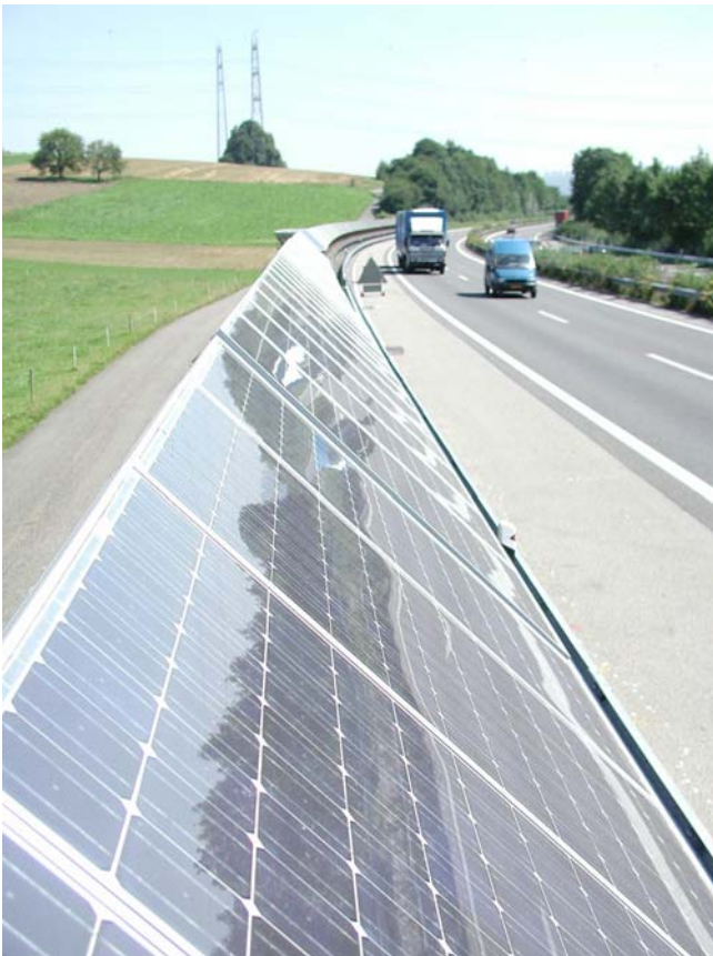
Figura 2: Parte dell'impianto verso EST e relativa curvatura dell'autostrada.
