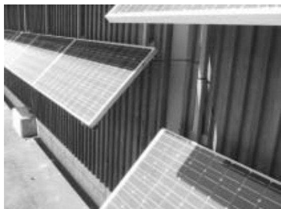
Fig. 22: Dieses Bild zeigt die Teilbeschattung auf der unteren Modulreihe am 28.6.2001./13.00 Uhr
