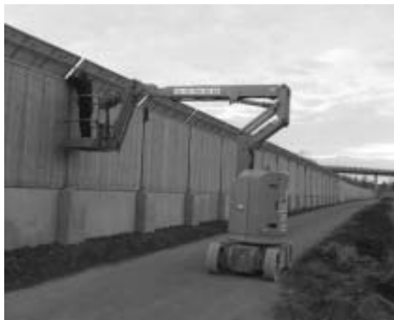
Fig. 11 Die Länge der Anlage erforderte entsprechende Montagegeräte. Fahrbare Arbeitspodeste ermöglichten eine speditive Anlage-Installation.
