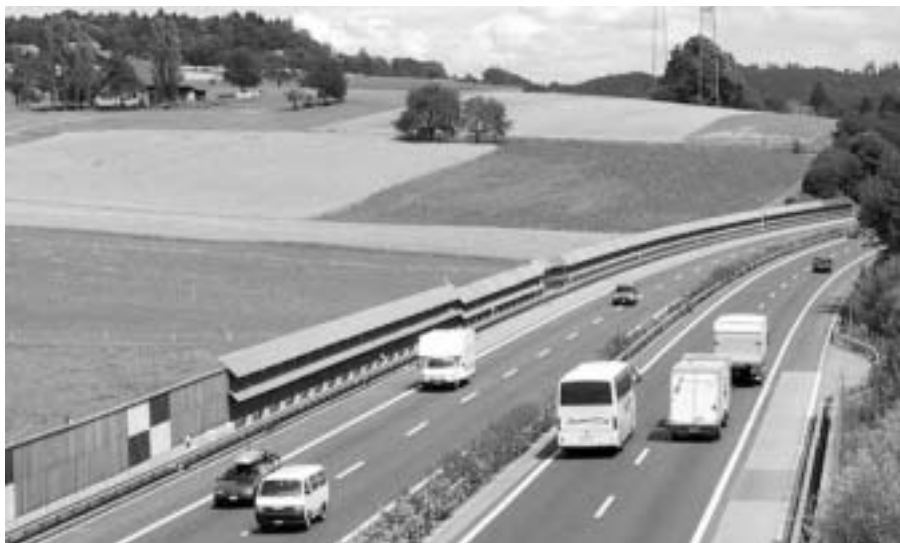
Fig. 1 Ansicht der fertig erstellten Anlage a.d. Autobahn A1 in Safenwil, Fahrspur Zürich-Bern.
