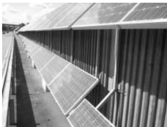
Fig. 23: Schattengrenze wieder über der Modulreihe ab etwa Ende Aug. Foto v 18.9.2001.
