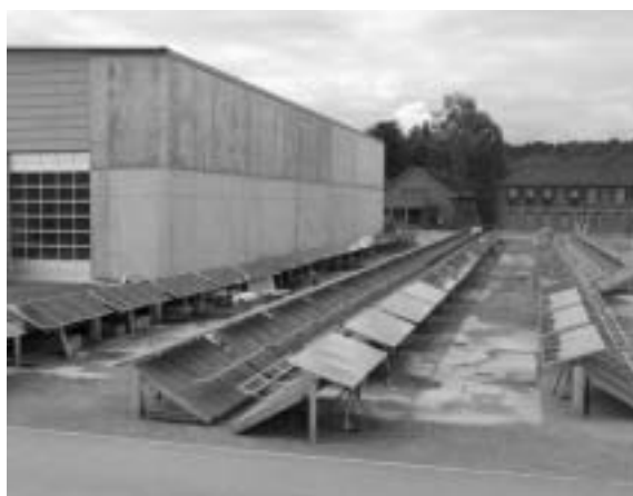
Fig. 7 Ansicht des Vormontage-Werkareals in Frick, wo auch die Wandelemente gefertigt wurden. Stand der Arbeiten am 2. Okt. 2000.
