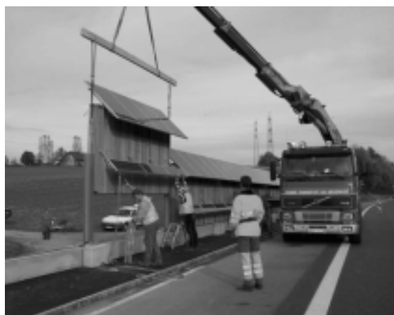
Fig. 8 Beginn der PV-Schallschutzanlage-Montagearbeiten vor Ort auf der A1 in Safenwil. Stand der Arbeiten am 30. Okt. 2000.
